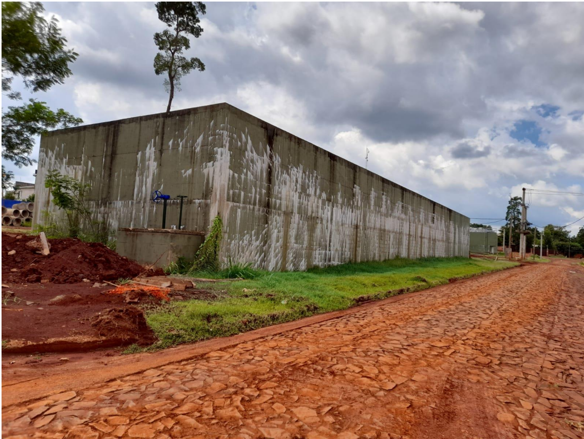
Fotografía N° 2- Estado actual de la obra.
