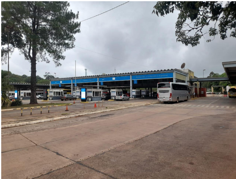
Imagen 04 – Área ingreso al país-casillas de control migratorios. (fuente: propia)
