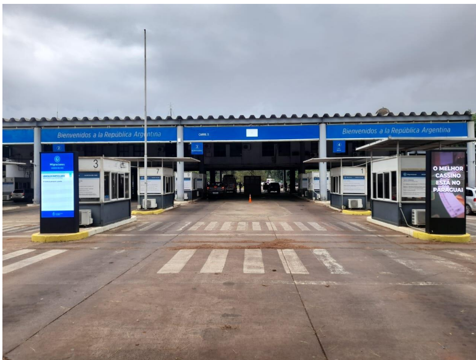
Imagen 05 – Área ingreso al país-casillas de control migratorios. (fuente: propia)
